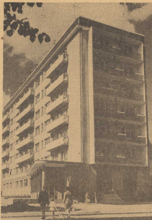
3 Adres: Malopolska 45. Autor: mgr inż. arch. Ryszard LIPKOWSKI. Biuro Projektów: Wojew. Biuro Projektów w Szczecinie. Wykonawca: SPBM Nr 1. Kierownik budowy: L. TRZMIELOWSKI. M. KRZ. GLICKI. Inwestor: MDOB. Inspektor nadzoru: Jerzy SZYDŁOWSKI. Kondygnacji: 7. Struktura mieszkań: M3, M4, M5, M6. Kubatura: 10 425 m sześć. Powierzchnia użytkowa: 2 606 m kw. Izby: 138. Koszt 1 m. powierzchni użytk.: 2 800 zł.
