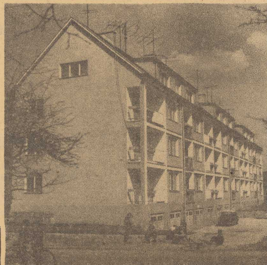
9 Adres: Herbowa 9/11. Autor projektu: inż. Stanisław SPACHOWIAK. Biuro projektów: „Miestoprojekt”, Szczecin. Wykonawca: SPBM 2. Kierownik budowy: Julian SOCHA. Inwestor: Spółdzielnia Mieszkaniowa „Wspólny Dom”. Inspektor nadzoru: inż. Henryk NARDY. Ilość kondygnacji: 3 plus poddasze. Kubatura: 8 156 m sześć. Struktura mieszkań: M1, M2, M3, M4, M5, M6.
