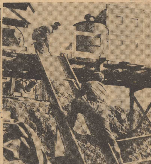
PIERWSZY BETON POD BLOK E-2
