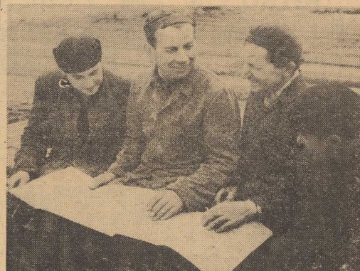
Na naszym zdjęciu: Zygmunta Marciniak (w motocyklowej czapce) w otoczeniu swej brygady na budowie w Wytwórni Wódek w Szczecinie.
