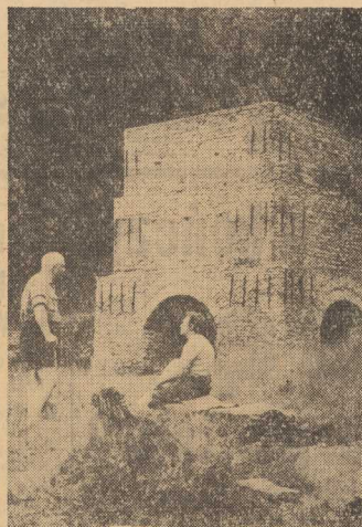
TAK WYGLĄDA za- bytkowy piec kuchen- ły do wypiekania rud i żelaza. Zachował się on w miejscowości Omasa na Węgrzech. (Foto CAF)
