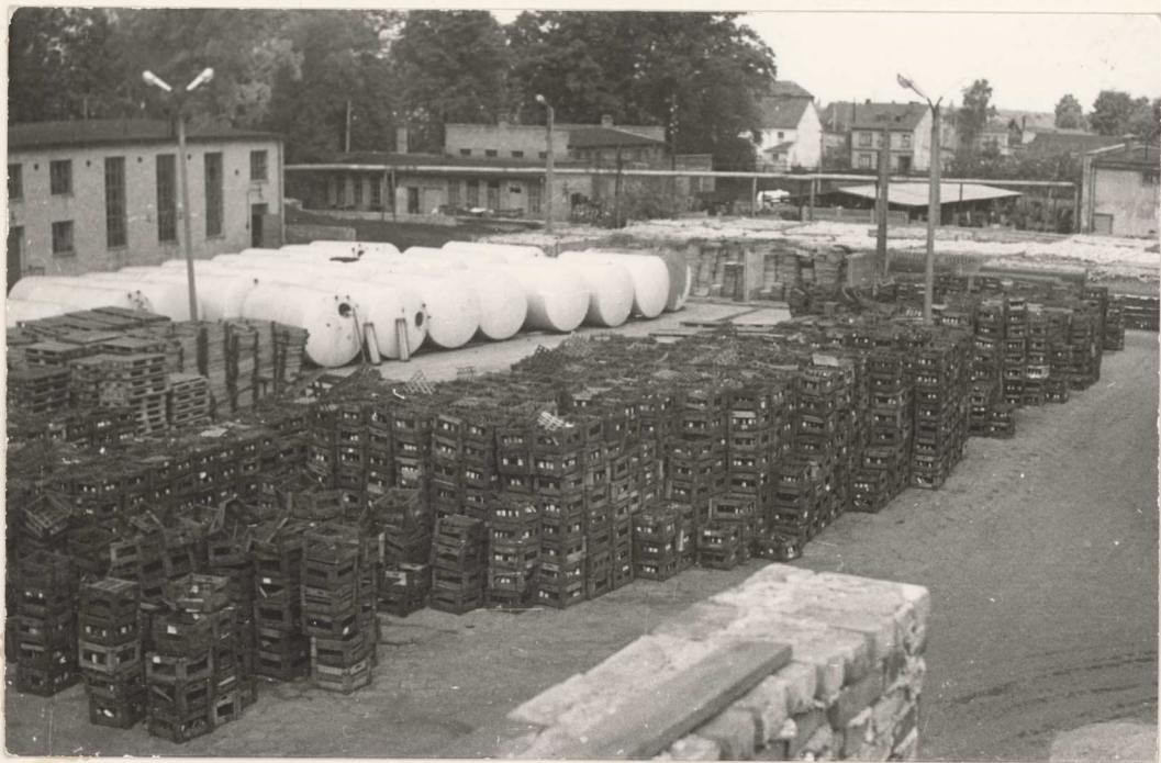
Fragment Zakładu - w głębi warsztaty mechaniczne, z lewej kotłownia
