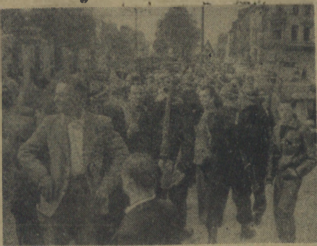
Zandarmi rozprawiają robotników budowlanych, którzy zajęli tunel Porte Louise.
