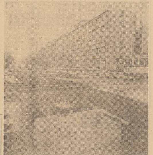
MAGISTRALA ciepłownicza przeprowadzona jest już pod torowiskiem na ul. Krzywoustego. Trwa szalowanie kolejnej betonowej komory. Foto: Z. Jodkowski
