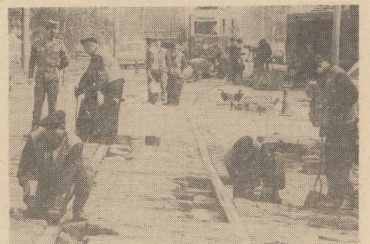
ZOŁNIERZE SPOT dowodzeni przez kpr. Grzegorza Komorowskiego pracują przy remoncie domu na ul. Matejki. Prace nadzoruje majster WPKM Edward Oleśkiewicz.
