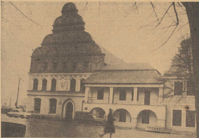
LADNE, PRAWDA? W odbudowanym starym ratuszu mieści się stargardzka Miejska Rada Narodowa i jej Prezydium. Nowe, zbudowane po uprzątnięciu gruzów domy stanęły już vis a vis starego ratusza. Niebawem znajdzie się on w samym centrum nowego pięknego miasta. (wit)
