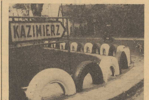
NA KILKU lubelskich trasach wylotowych, stare zużyte opony samochodowe służą jako zabezpieczenie dla pojazdów, amortyzując ewentualne uderzenia samochodów w wypadkach poślizgów. CAF — Michoeki
