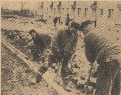
W DĄBIU przy nowo zbudowanym osiedlu brygady MPD wykonują obecnie nową nawierzchnię drogi, prowadzącej do miasta.
