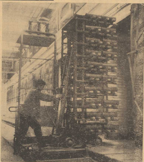
Na zdjęciu: nowa partia sączków ceramicznych na specjalnym podnośniku wjeżdża na „transwajl” elektryczny, którym zostanie odtransportowana wprost do suszarni.
