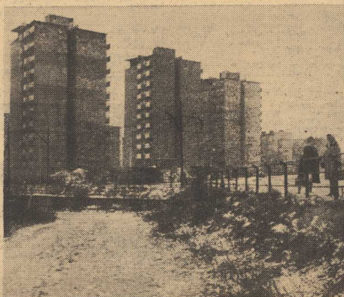
Na osiedlu spółdzielni „Wspólny dom” przy ul. Mieszka I przybył jeszcze jeden wieżowiec...
