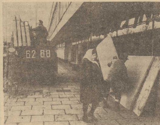
SZYBKO i sprawnie trwają prace przy zabezpieczeniu zdeformowanych sklepów. Ponieważ nie wszędzie starczyło szyb — w niektórych witrzynach zakładano maty i płyty pilśniowe. Foto: St. Cieślak
