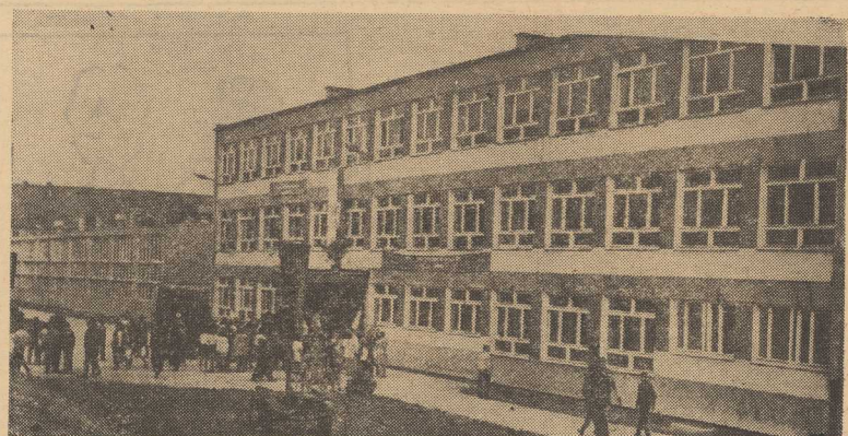
OTWARCIE nowej szkoły przyzakładowej przy FUB „Hydroma” zapewni młodzieży bardzo dobre warunki do nauki. Na zdjęciu: moment przekazania dwóch budynków szkolnych ich użytkownikom. Foto: St. Ciaslak
