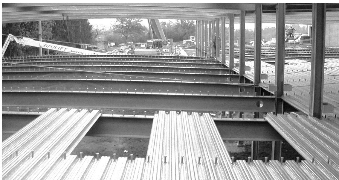
Ryc. 2.7. Montaż stropu zespolonego z wykorzystaniem blach profilowanych
