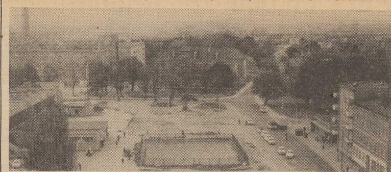
Osiedle „Ustronie” przy ulicach Budziszyńskiej i Włocławskiej.
