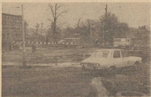
SKRZYŻOWANIE ul. Mieszka I i ul. Wierzbowej. Tu roboty można było przeprowadzić szybciej.
