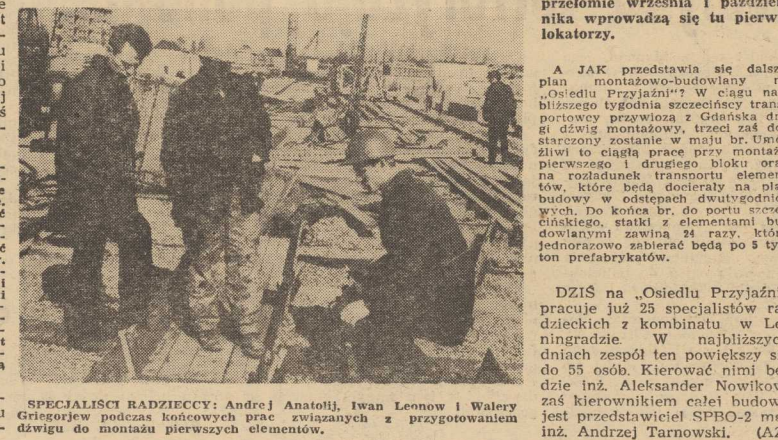
SPECJALIŚCI RADZIECCY: Andrzej Anatolij, Iwan Leonow i Walery Gregorjew podczas końcowych prac związanych z przygotowaniem do montażu pierwszych elementów.
