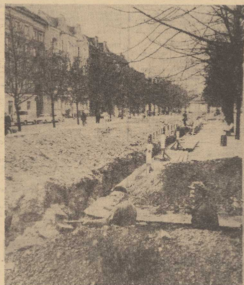
DOBIEGAJĄ końca prace przy budowie wykopów pod instalację wodną przyszłej alei fontann. Na zdjęciu: pracownicy MPWiK wyrównują ściany wykopu pod rurociągi.
