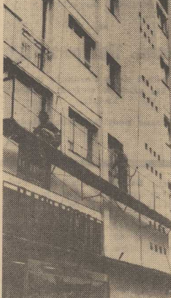
NA ZDJĘCIU: odnawianie elewacji budynku przy zbiegu al. Niepodległości i ul. Wielkiej, przy zastosowaniu ruchomego rusztowania.
