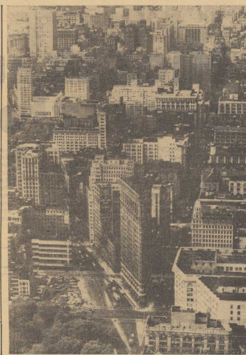
CENTRUM Nowego Jorku z lotu ptaka. Na I planie jeden z najstarszych wieżowców metropolii — Flatiron Building ukończony w 1902 r.
