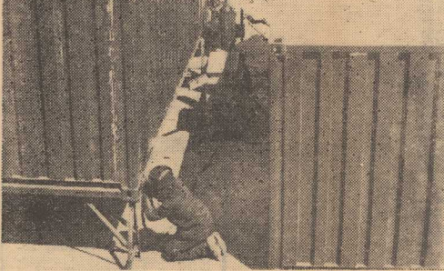
W FABRYCE Kontenerów „Unikon” trwają przygotowania do uruchomienia na skalę przemysłową produkcji kontenerów licencyjnych. Dotychczas wyprodukowano informacyjną serię 55 sztuk uniwersalnych kontenerów 20-stopowych.
