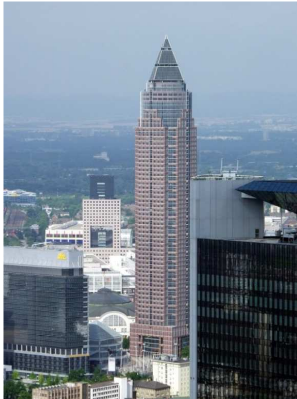
Rys. 3.39. Budynek Messturm, Frankfurt
