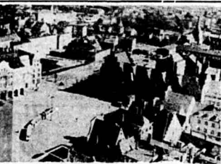
Nowo wybudowany Rynek w Rostoku
