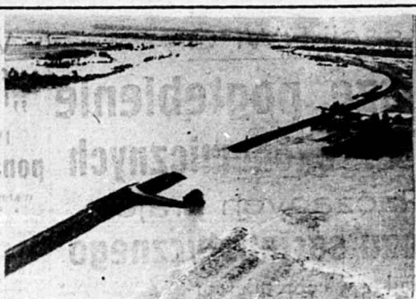
PRZERWANY wał przeciwpowodziowy na Wiśle w rejonie Ujście Solne. CAF fot. Grzęda
