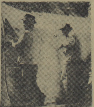
Niedosięgnięci blacharze — Józef Zdzankiewicz i Władysław Olech wykonują ostatnie prace na dachu.
