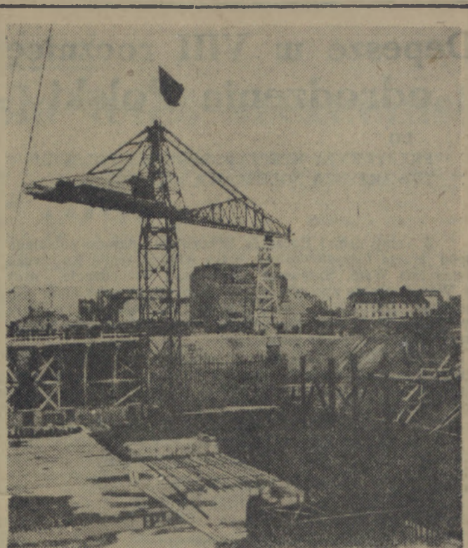
W przeddzień Święta Odrodzenia położone zostały pierwsze warstwy betonu pod fundamenty wysokościowej części Pałacu Kultury i Nauki.
