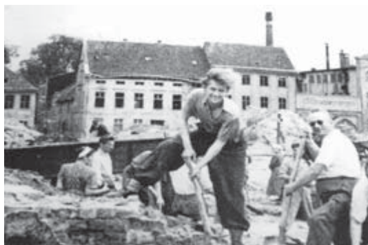
Rzemieślnicy przy odgruzowywaniu Koszalina.
