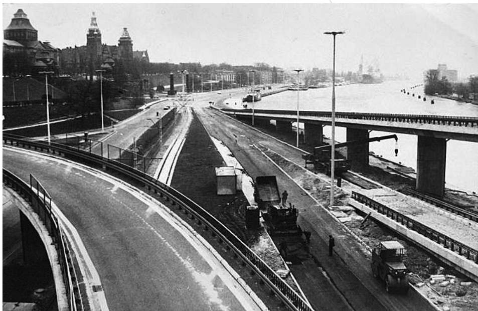
Budowa Trasy Zamkowej
