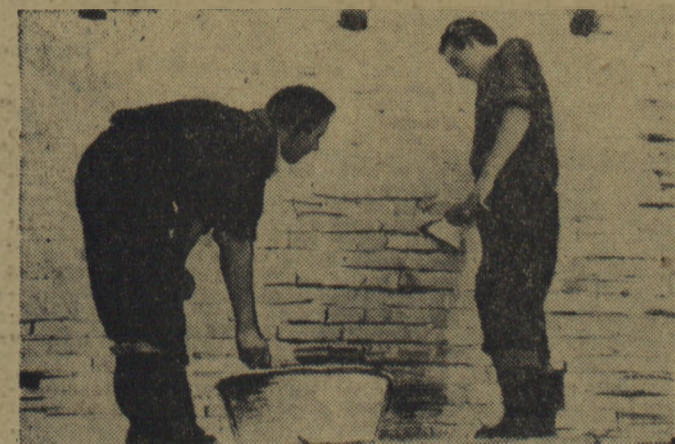
Bracia Szmaja przy budowie Teatru. Niestety, praca ta została od 3-ich tygodni przerwana.
