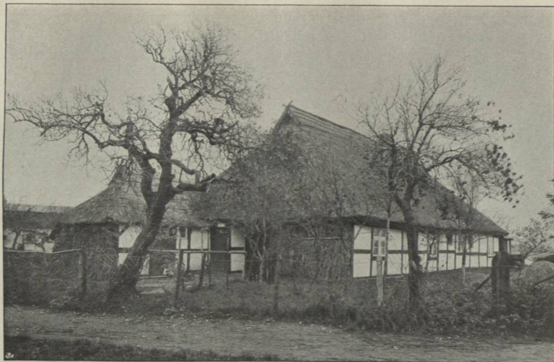
Fig. 11. Deep; Fischerhaus mit Stallvorbau unter eigenem Satteldache; die Wände der Westseite durch vorgestellte Rohrbündel besonders geschützt.
