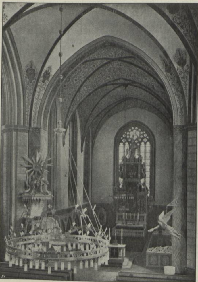
Fig. 49. Greifenberg; Marienkirche, Blick in den Hohen Chor.
