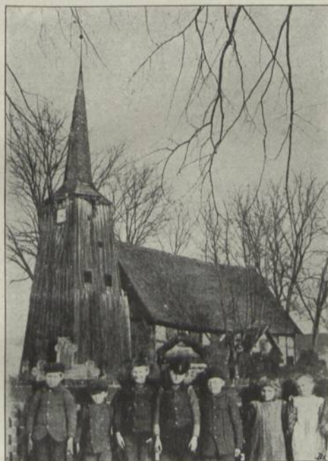
Fig. 156. Woedtke; Kirche vor dem Abbruche.
