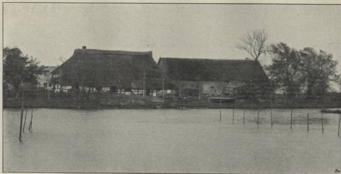
Fig. 14. Deep; altes Bauernhaus, neuer Stall und Scheune unter einem Dache.
