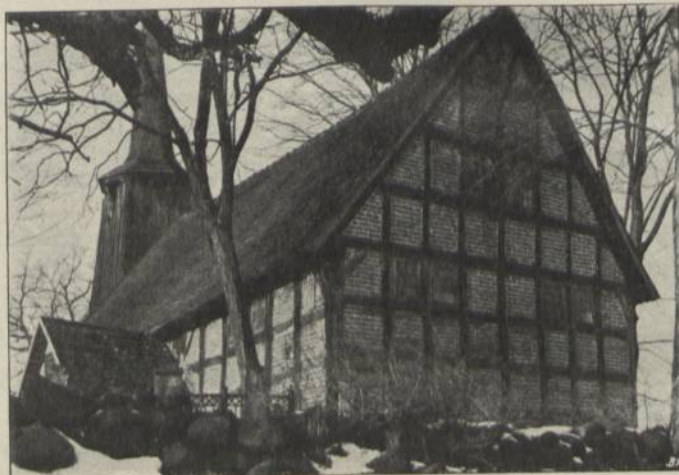
Fig. 155. Woedtke; Kirche vor dem Abbruche.
