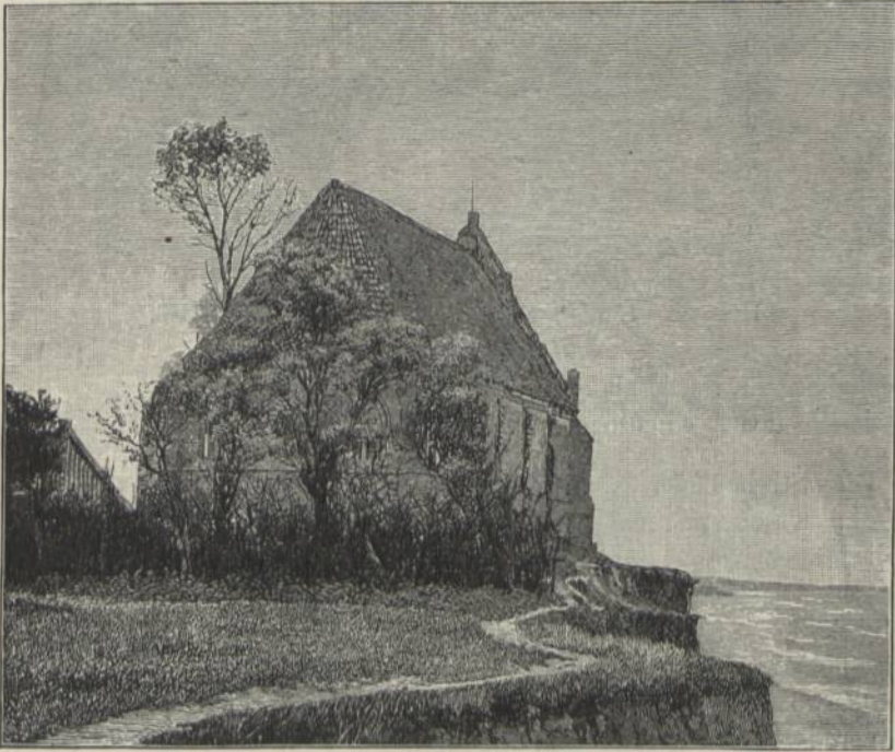
Fig. 68. Hoff; ehemalige Pfarrkirche vor 1873.
