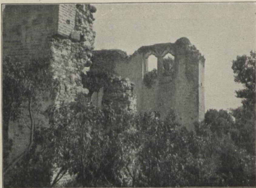
Fig. 19. Daber; Das Neue Haus vom Bergfriede aus gesehen.
