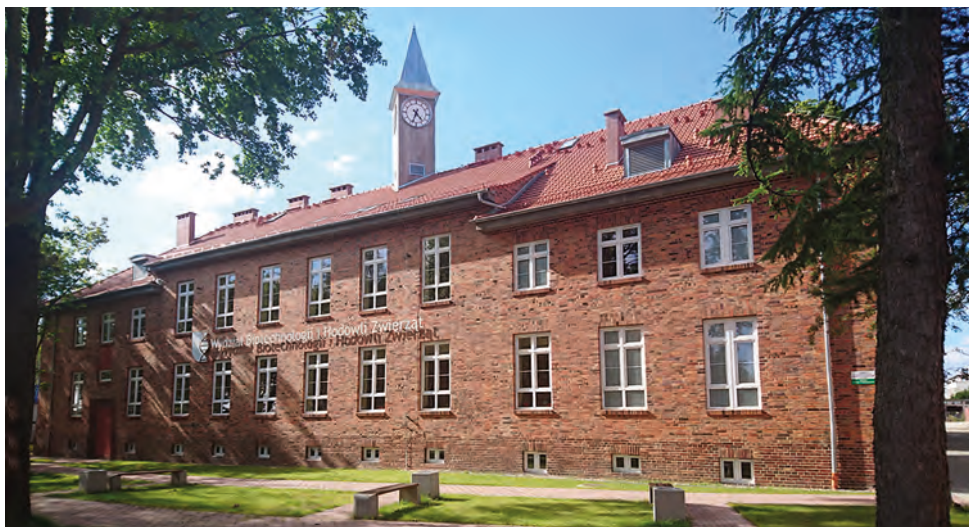
Dziekanat przy ul. Klemensa Janickiego 32 po remoncie
