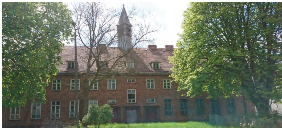
Budynek dziekanatu przed remontem – kampus przy ul. Klemensa Janickiego 32
