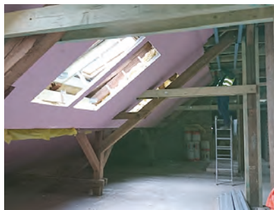
Remont poddasza przy ul. Janickiego 32
