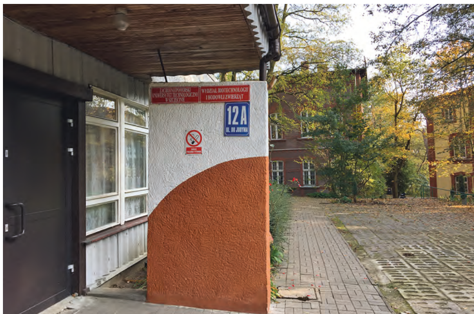
Budynek przy ul. Doktora Judyma 12A, w tle budynek nr 10
