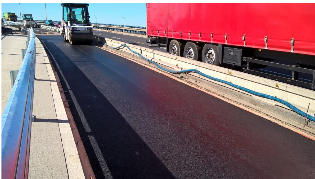
Rys. 2-21. Zagęszczanie warstwy SMA-MA [fot. P. Adamczyk, Eurovia Polska]
