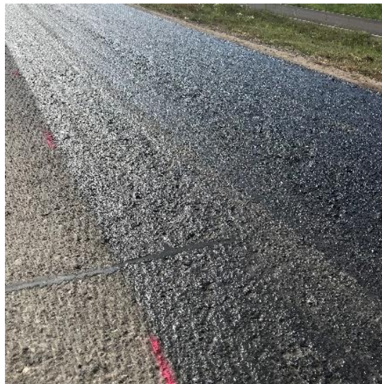
Rys. 5-12. Skropienie nawierzchni
