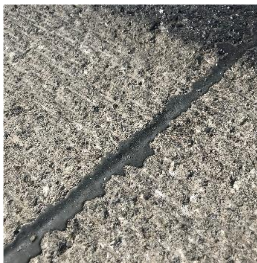
Rys. 5-11. Wypełnienie szczelin zalewą
