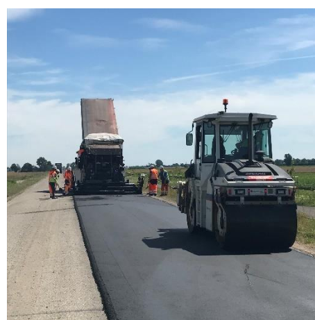
Rys. 5-16. Zagęszczanie mma
