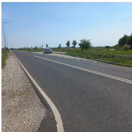
Rys. 5-19. Przegląd stanu nawierzchni drogi DW 265 z warstwą AC AF po 4 latach eksploatacji
