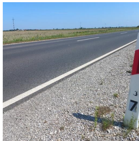
Rys. 5-19. Przegląd stanu nawierzchni drogi DW 265 z warstwą AC AF po 4 latach eksploatacji
