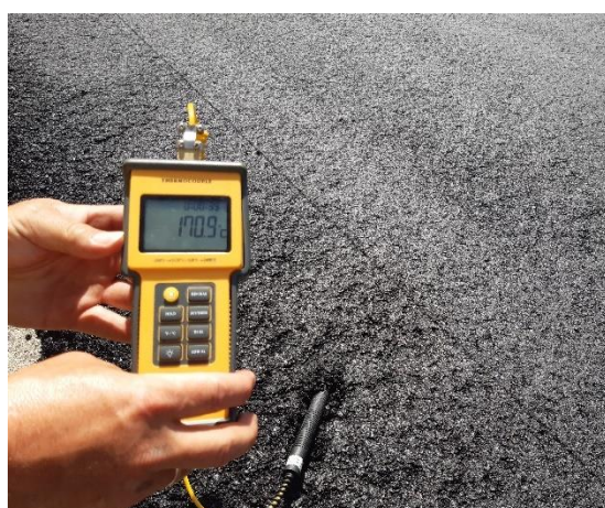
Rys. 5-15. Temperatura wbudowania mma
