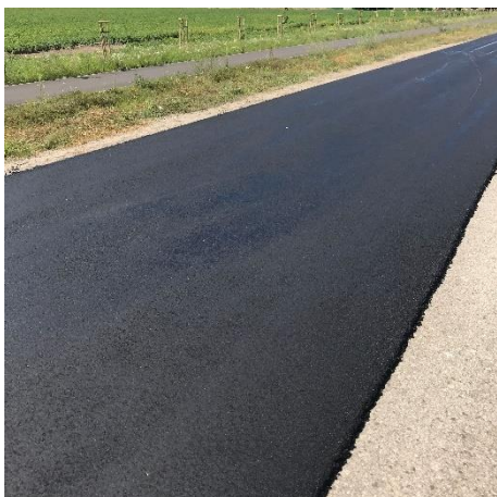
Rys. 5-17. Warstwa przeciwspekaniowa
