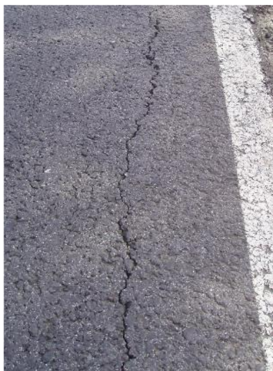
Rys. 2-8. Przykład spękania „góra-dół” (ang. top-down)
