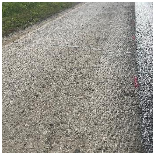
Rys. 5-10. Sfrezowana powierzchnia
