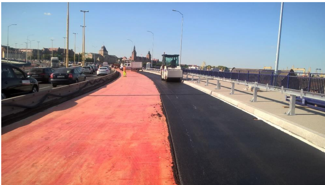
Rys. 2-19. Warstwa hydroizolacyjna z metakrylanu metylu zabezpieczona warstwą z mieszanki SMA-MA, [fot. P. Adamczyk, Eurovia Polska]
