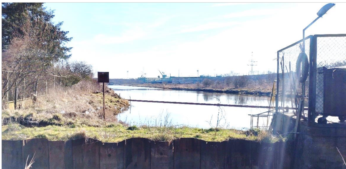
Ryc. nr 52. Widok basenu przy elektrowni „Pomorzany”, od strony ul. Szczawiowej. Jest to teren niedostępny dla osób postronnych. Brzegi basenu nie są zagospodarowane. Po prawej stronie od kanału przebiega linia kolejowa Szczecin-Stargard. Rok 2022. Zdjęcie własne.
