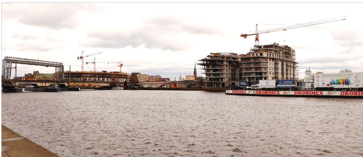
Ryc. nr 33. Widok nowo powstającej zabudowy mieszkaniowej na prawym brzegu Odry Zachodniej, na Kępie Parnickiej i na części Łasztowni. Rok 2023. Zdjęcie własne.
