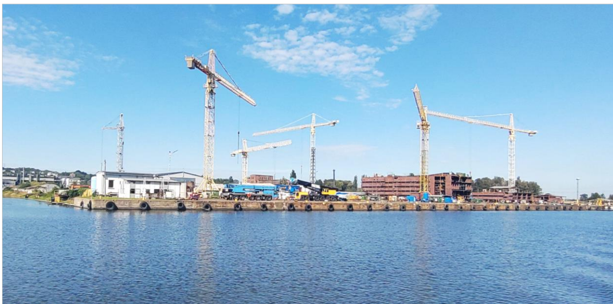
Ryc. nr 11. Widok terenów dawnej fabryki papieru Skolwin w Szczecinie. Stosunkowo szybko wyeksploatowana zabudowa pofabryczna została wyburzona, a miejsce po budynkach i obiektach zajęły nowe rodzaje działalności – na zdjęciu budowa kadłubów statków na Nabrzeżu Fant. Jest to przykład nie zaplanowanej wcześniej formy przekształceń funkcjonalnych i przestrzennych obszarów przemysłowych. Rok 2023. Zdjęcie własne.
