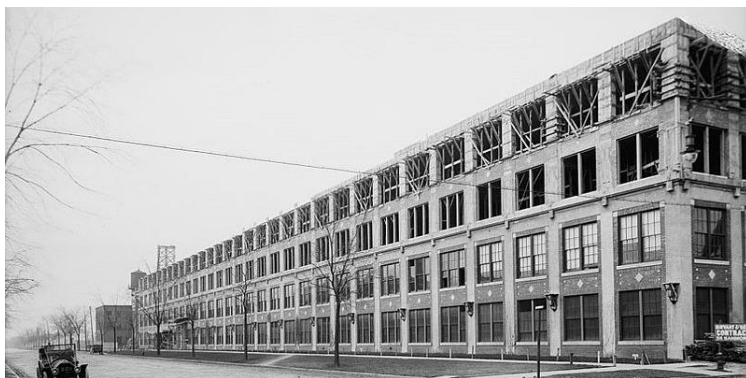
Ryc. nr 5. Budynek warsztatów nr 10 Packard Automobile Plant w Detroit. Widok elewacji: betonowe ramy, wypełnione przeszkloniami zapewniały dużo światła dziennego we wnętrzach. Źródło: https://www.researchgate.net/figure/The-facade-of-the-No-10-workshop-of-the-Packard-Automobile-Plant-Source-14_fig5_341032818 Dostęp: 03.03.2023
