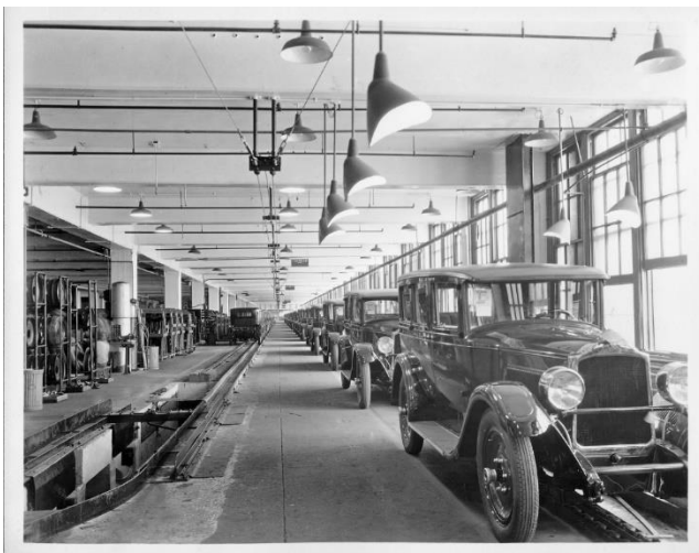
Ryc. nr 6. Widok wnętrza hali produkcyjnej Packard Automobile (w 1927 roku), z przeszkleniami na całą rozpiętość konstrukcji, czyli od słupa do słupa – takie rozwiązanie wpuszczało dużą ilość światła dziennego. Źródło: https://digitalcollections.detroitpubliclibrary.org/islandora/object/islandora%3A153757 Dostęp: 03.03.2023
