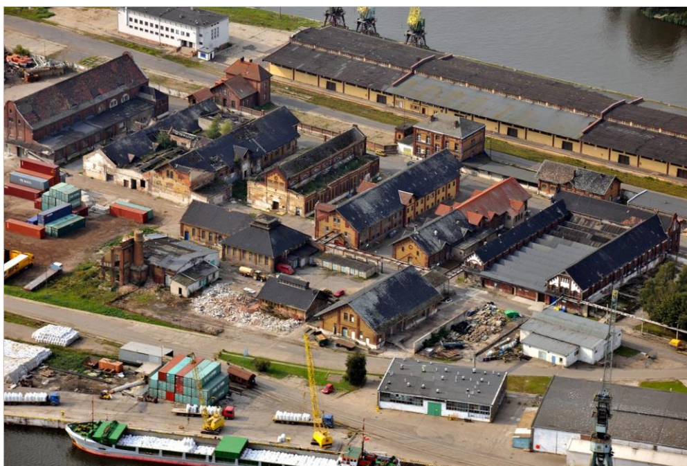
Ryc. nr 23. Fragment wyspy Łasztownia w Szczecinie. Zespół danej rzeźni miejskiej około roku 2007. Na górze zdjęcia widoczne magazyny przedsiębiorstwa Gryf przy Nabrzeżu Starówka, rozebrane w związku z rewitalizacją bulwarów. W lewym górnym rogu biały budynek biurowy został wyburzony w 2021 roku na potrzeby budowy Muzeum Morskiego. Autor: M. Czasnojęć.
