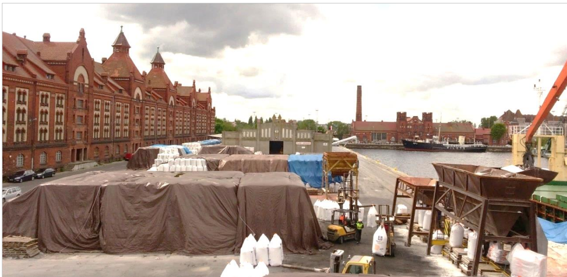
Ryc. nr 50. Dawne zabudowania portu wolnocłowego w 2019 roku. Nabrzeża i historyczne magazyny są cały czas użytkowane na potrzeby przeładunków i składowania. Teren jest niedostępny dla osób z zewnątrz, ze względu na niebezpieczeństwo podczas prac prowadzonych na terenie portu. Zdjęcie własne.
