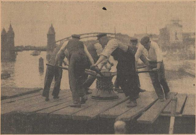
Die Hebefetten werden unter dem Schiff hindurchgewunden.
