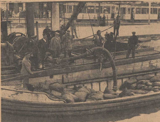
Der Prahm ist gehoben, das Wasser wird ausgedrückt.
