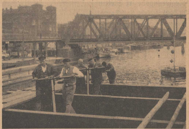
Auf den Hebefahrzeugen werden die Ketten angezogen.
