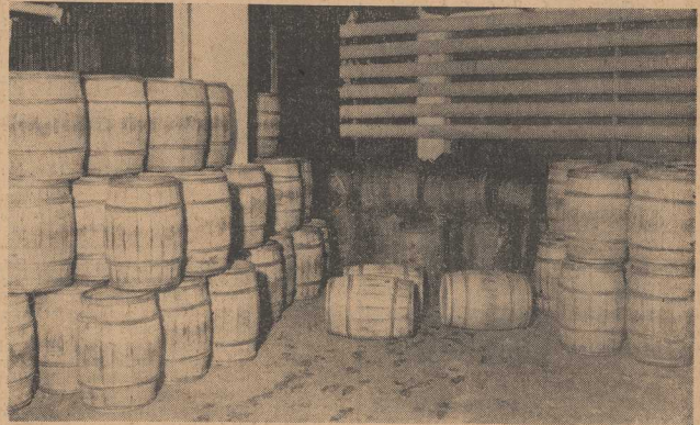
Ein Teil des Berinaschälagers. Im Hintergrunde an der Wand Rohre, in denen Ammoniak verdampft und die sich deshalb mit einer Schneeschicht bedecken.
