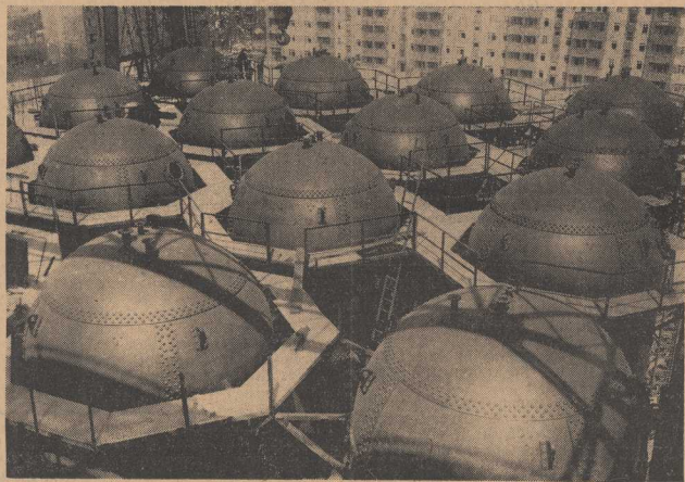
Die größte Speicherbatterie des Kontinents.
