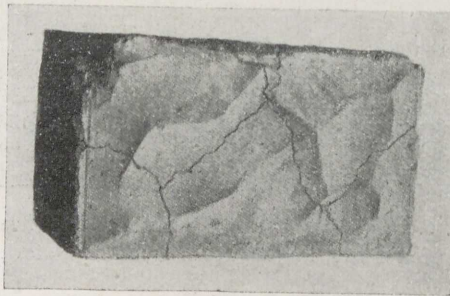
Abb. 7. Treibriße an einem Zementmauerstein, hervorgerufen durch ungeeignetes Zuschlagmaterial.
