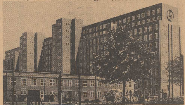
Das jetzt fertiggestellte Siemens-Hochhaus
