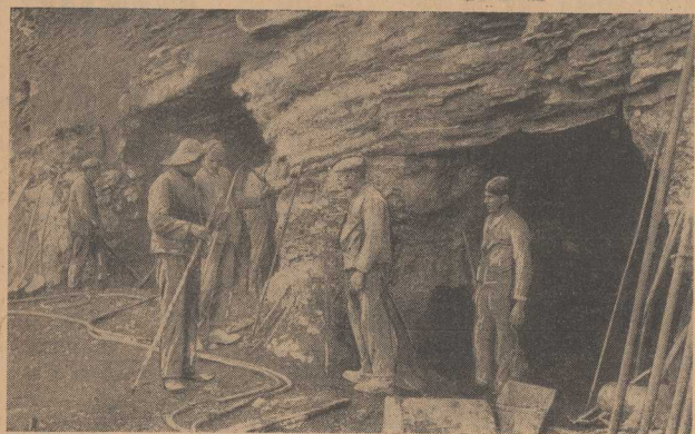
Außerschlitten der Tunnelstrecke in 1900 Meter Höhe.
