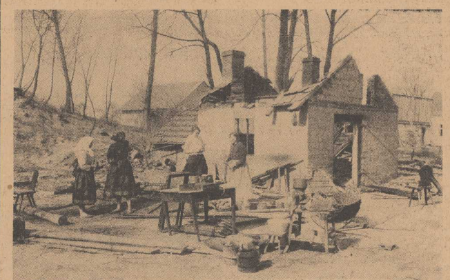
Am Sonntag wurde das Spreewaldorfer Pflanzhaus, das auch als Ausflugsort bekannt ist, von einem verheerenden Großfeuer heimgesucht. Die Flammen vernichteten nicht weniger als fünfzehn Gebäude vollständig. Unsere Aufnahme zeigt die Ruinenruinen eines zerstörten Bauernhauses mit der wenigen Habe, die sie aus ihrem brennenden Hause zu retten vermochten.
