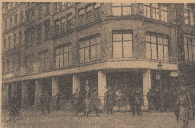
Die Kolonnaden sind jetzt fertig und wurden heute dem Verkehr übergeben. Unser Bild zeigt die jetzt „Breite“ Straße von der Wallnberstraße aus.
