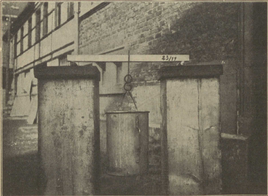
Abb. 7. Prüfung der Reinzement- und Zementmörtelbalken.
