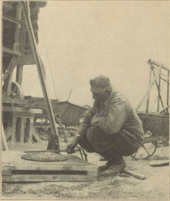
Abb. 45. Ausbreitprobe.
