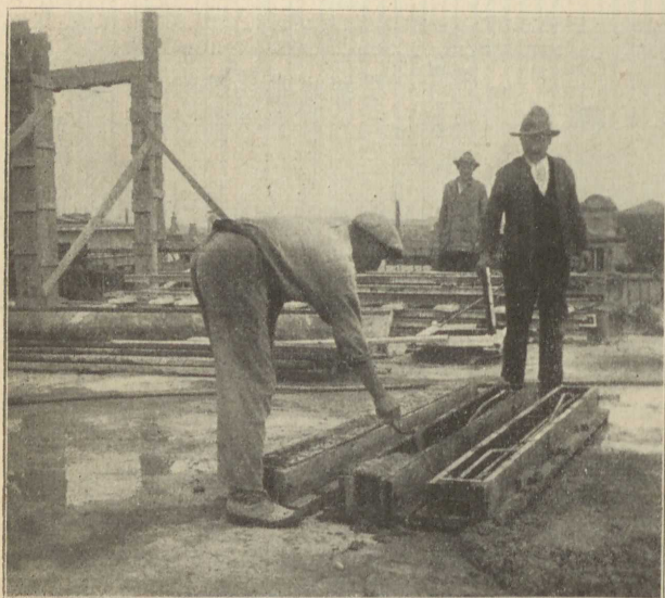
Abb. 32. Herstellung der Probekbalken.
