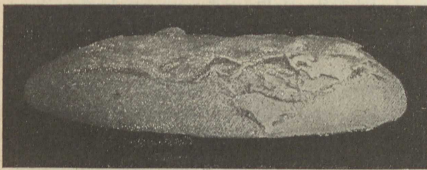
Abb. 5. Abblätterung infolge Treibens.
