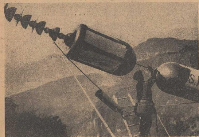
Bei der Montage der riesigen Isolatorenketten und Sprühstößkörper für die große Anlage hoch über den Gletscherglaciolen.
