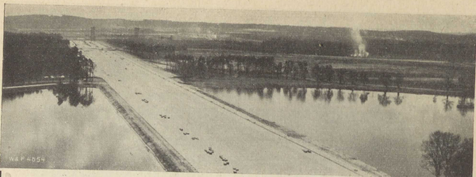
„Große Straße“ auf dem Nürnberger Parteitaggelände.
