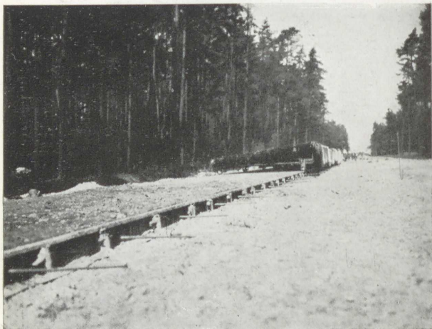
5. Ankereisen bei halbseitiger Herstellung
