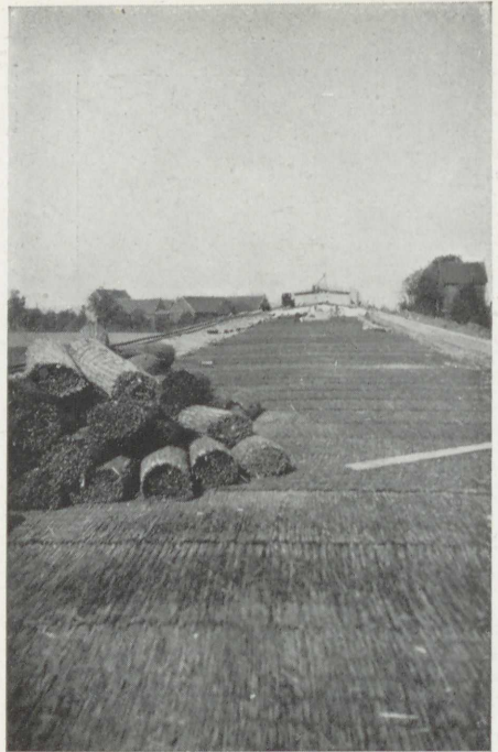
13. Abdecken des frischen Betons
