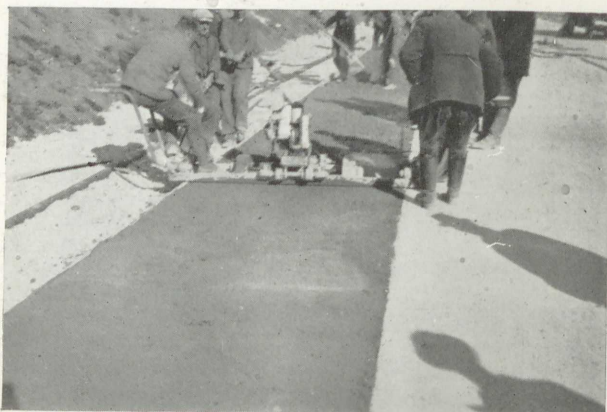
Ausführung von Randstreifen aus gefärbtem Beton
