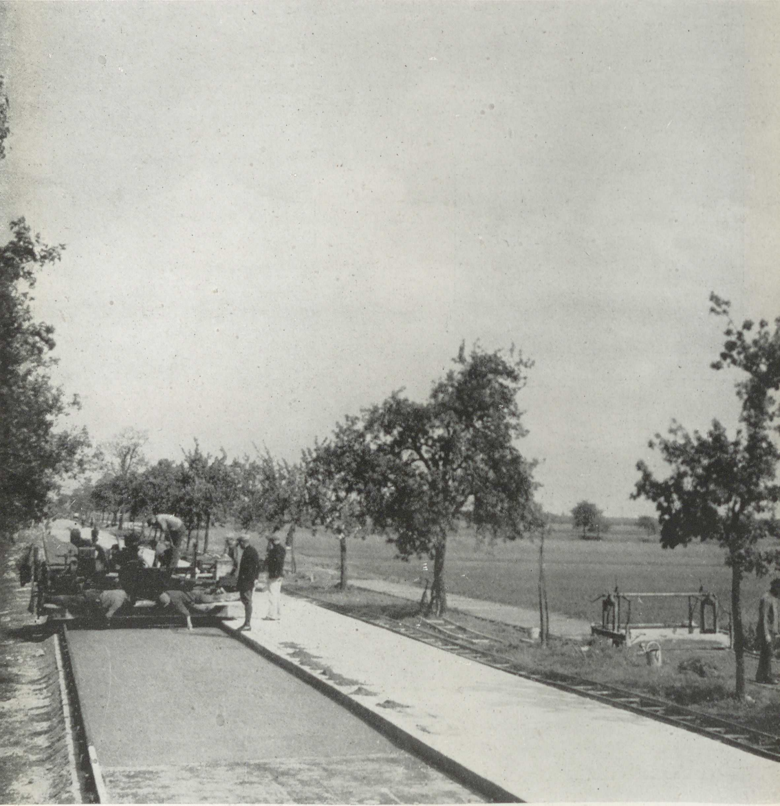
Landstraße in Mitteldeutschland in der Ausführung (Halbseitiger Einbau, rechts Radweg)
