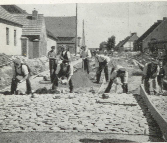
Ausführung einer Concretlithdecke
