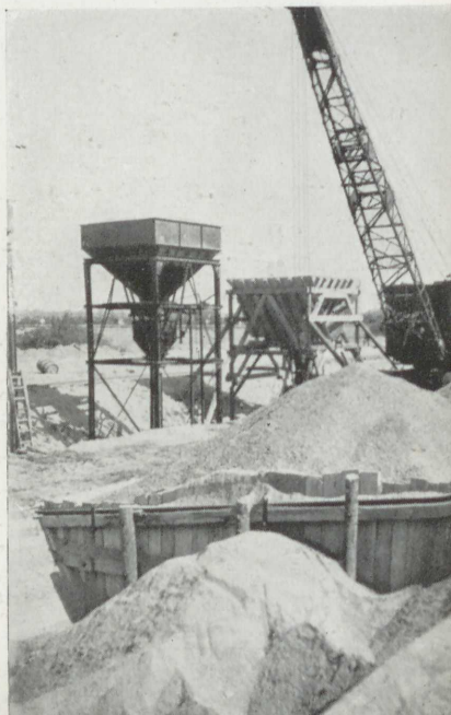
7. Beschickung der Meßsilos aus Vorratsbunkern durch Greifbagger
