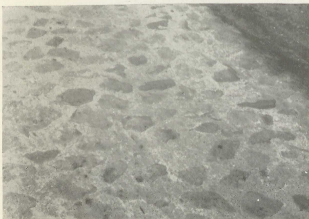
Oberfläche einer Concrelithdecke nach mehrjährigem schweren Verkehr
