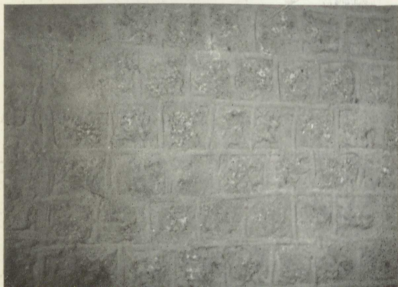
Fertig verfügte Oberfläche
