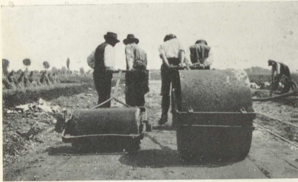
1. Verdichten des Planums durch Walzen
