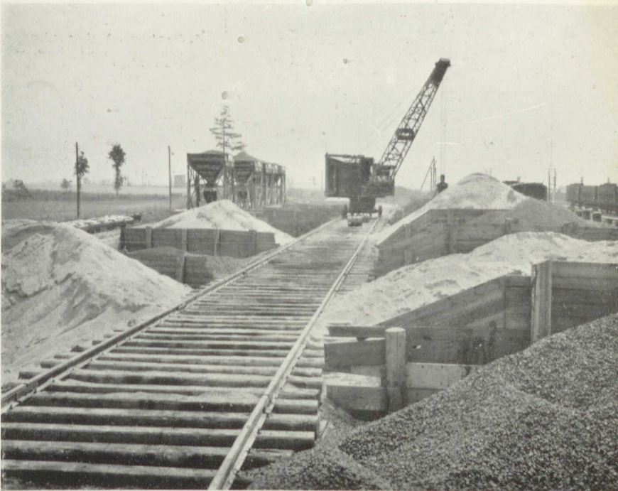
2. Lagerung der Zuschlagstoffe
