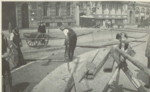
Herstellung eines Radweges von Hand
