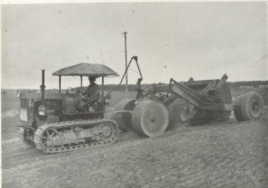
5. 4-m 3 -Schürwagen mit druckölgesteuerter Kippvorrichtung (Werkfoto Menck & Hambrock)
