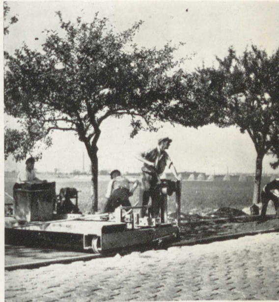
22. Leichter, von Hand ver- fahrbarer Vibrations- fertiger (Werkfoto H. Frisch)
