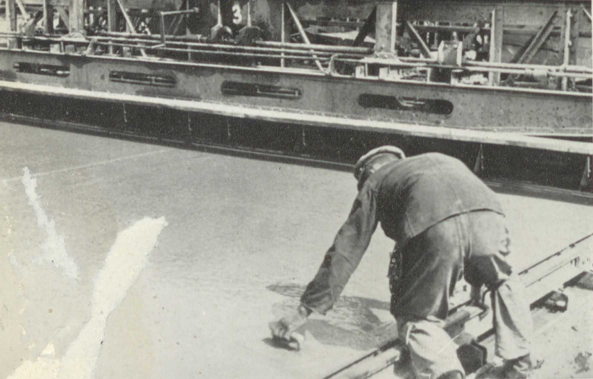
12. Decken- schluß durch Fertiger. Nur kleine Nach- arbeiten mit Reibebrett
