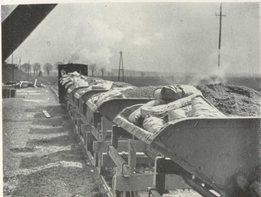
4. Transport der abgemessenen Zu- schläge und des Zementes zur Baustelle
