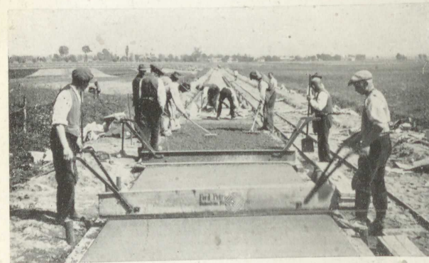
3. Verdichten des Oberbetons durch Handstampfböhlen
