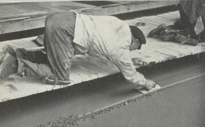
14. Freilegen der Fugen- eisen und Ab- runden der Kanten
