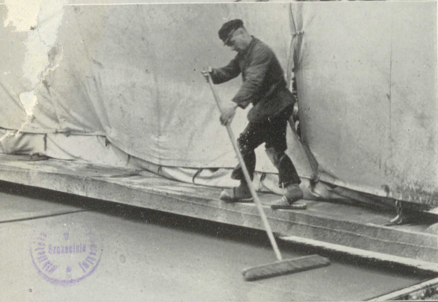
13. Abziehen der Oberfläche mit Besen
