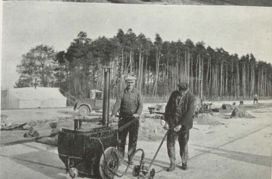
17. Ausgießen der Fugen
