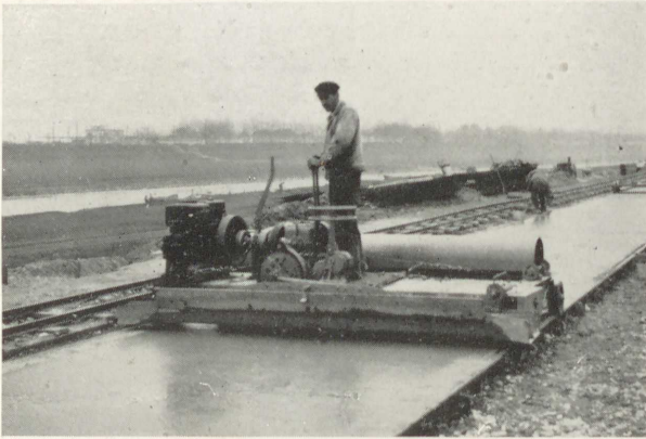
24. Hochfrequenz-Reichsstraßen-Fertiger (Werkfoto Jos. Vögele AG.)
